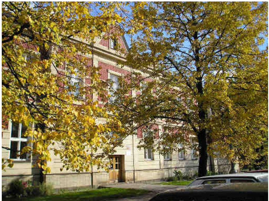
Stará budova školy z roku 1908.
